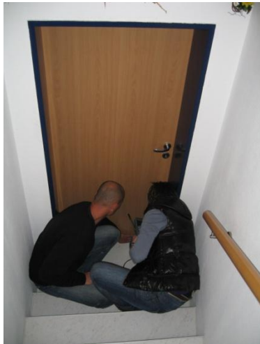
Bild 3: Abgang zum Kellerraum (Übergang beheizte – unbeheizte Zone)
